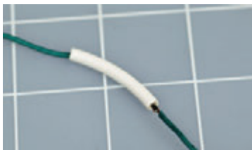
Рис. 3.42. Наденьте трубку на ваше соединение проводов
